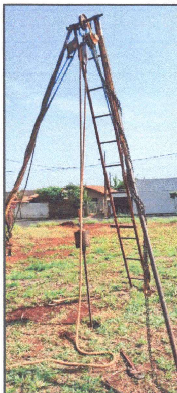
Foto 2 – Execução de Sondagem
