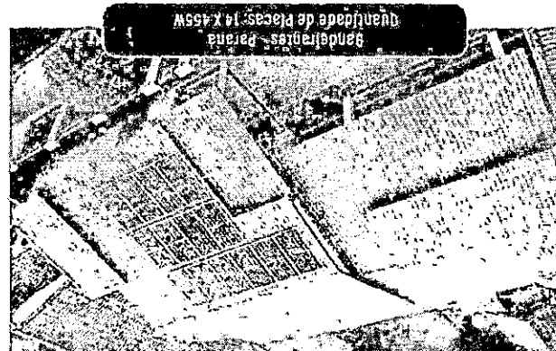
Paranaíba - Paraná Quantidade de placas: 36 X 540W
